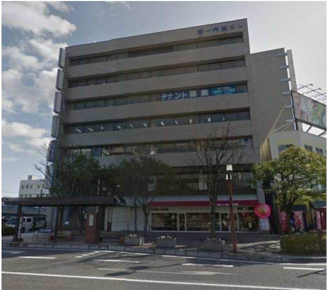
建物外観写真
